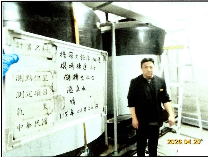
內容：儲槽出水口
